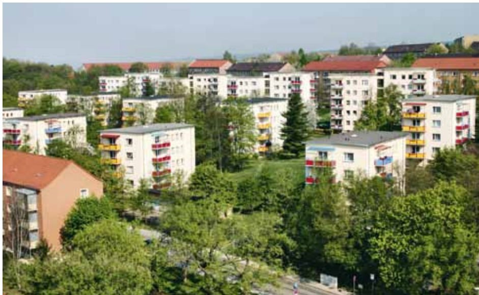
E.-E.-Kisch-Straße und Glück-Auf-Weg nach der Sanierung
