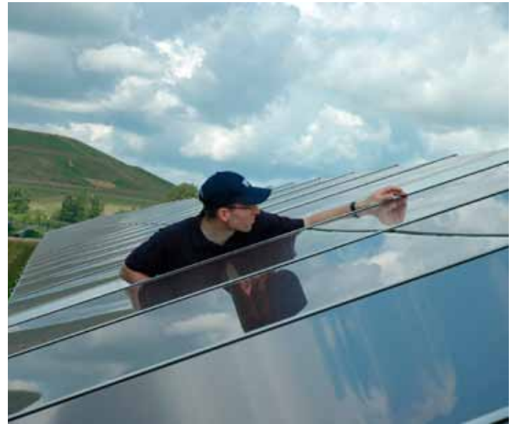
Solkraftwerk bei Ronneburg
