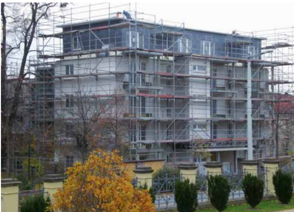
Blick auf den Rohbau
