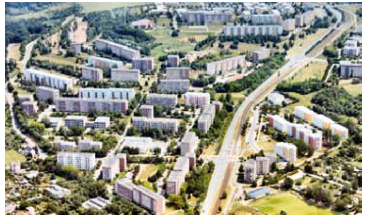
nach dem Abriss
