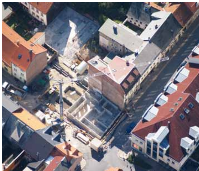
Luftbild der Baustelle – Herausforderung durch schwierige Baugrundbedingungen
