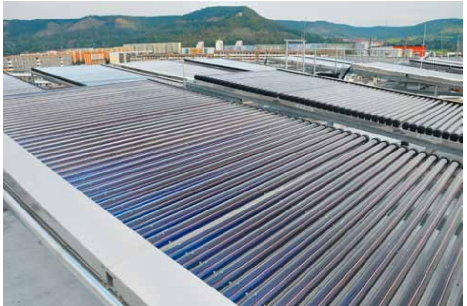
Montierte Solarthermieanlage
