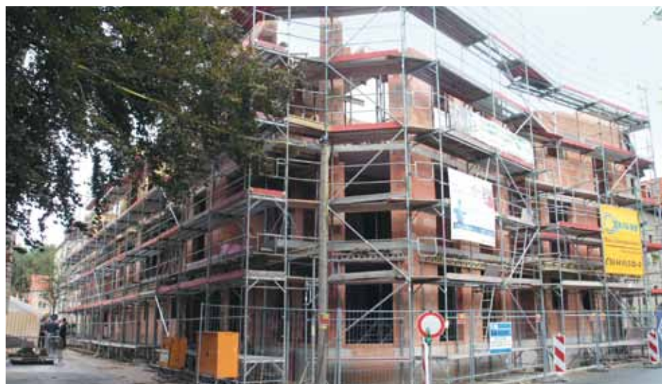
Quartier Gartenstraße/ Hausmühlenstraße – Rohbau
