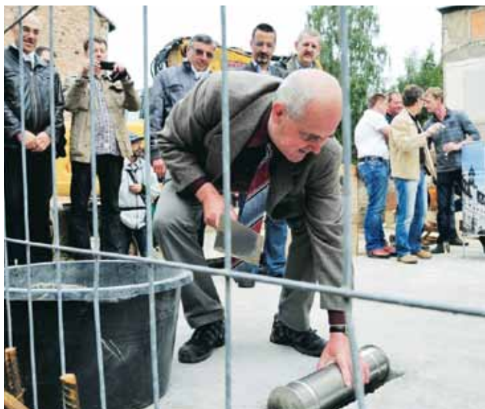
Grundsteinlegung durch Hermann Töpfer (Foto Ch. Vogel/Thüringer Allgemeine)
