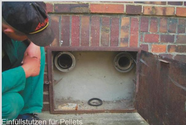
Einfüllstutzen für Pellets
