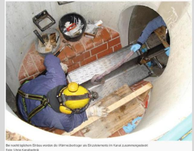
Bei nachträglichem Einbau werden die Wärmeübertrager als Einzellemente im Kanal zusammengesetzt
