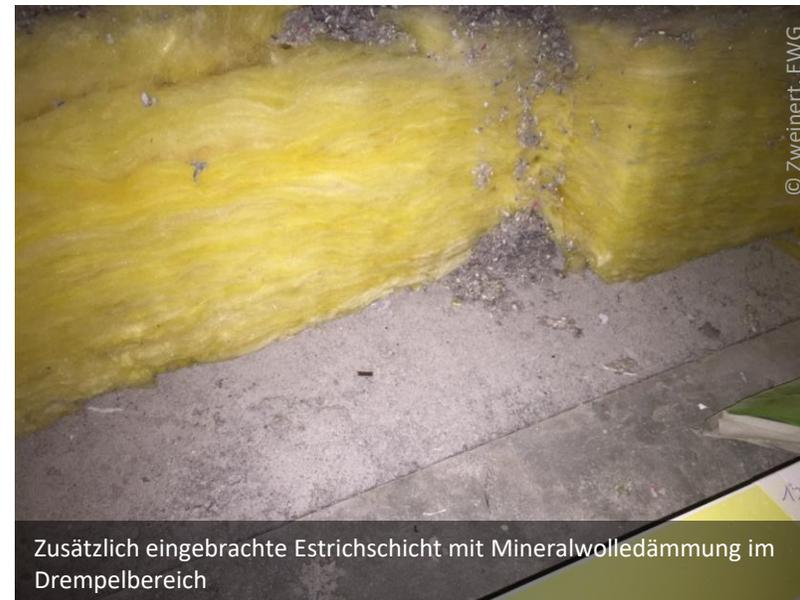
Zusätzlich eingebrachte Estrichschicht mit Mineralwollendämmung im
