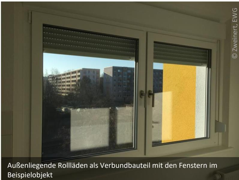
Außenliegende Rollläden als Verbundbauteil mit den Fenstern im
